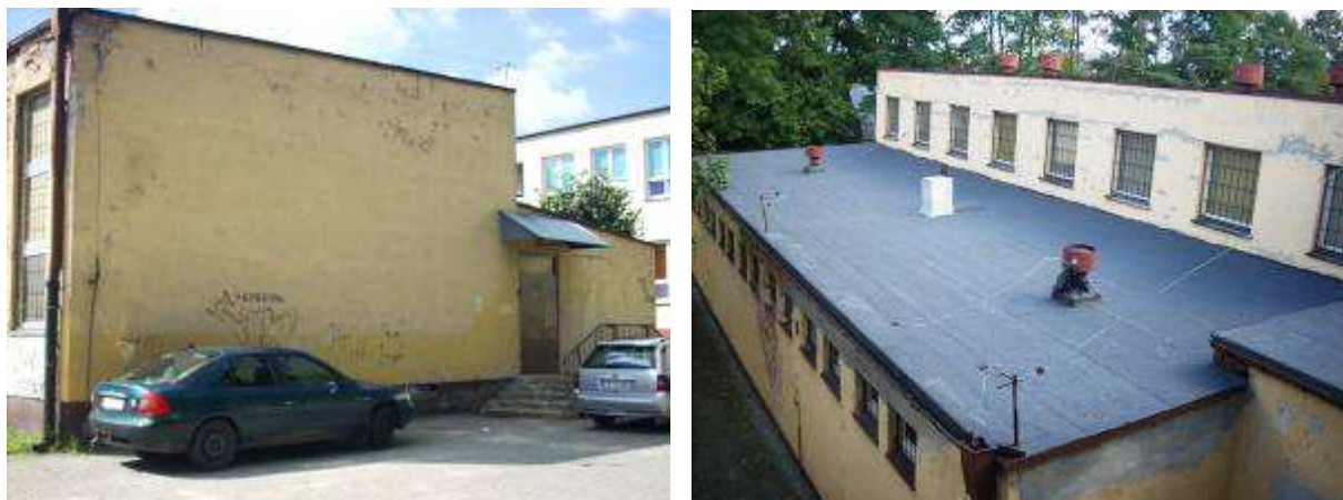
Rysunek 10 Widok elewacji północnej ali gimnastycznej oraz stropodachu zaplecza sali gimnastycznej
