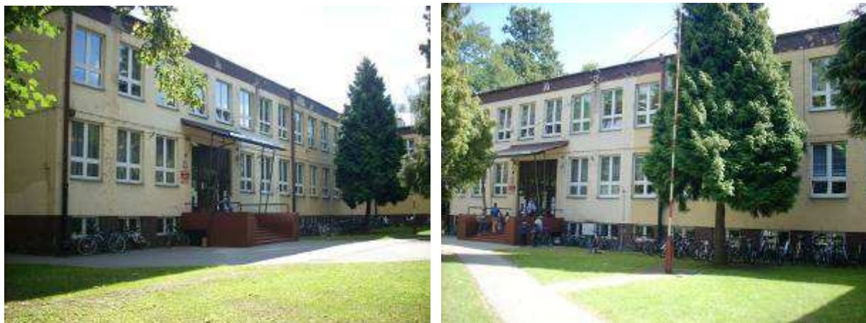
Rysunek 1 widok elewacji frontowej (zachodniej - wejścia głównego do budynku Szkoły Podstawowej)
