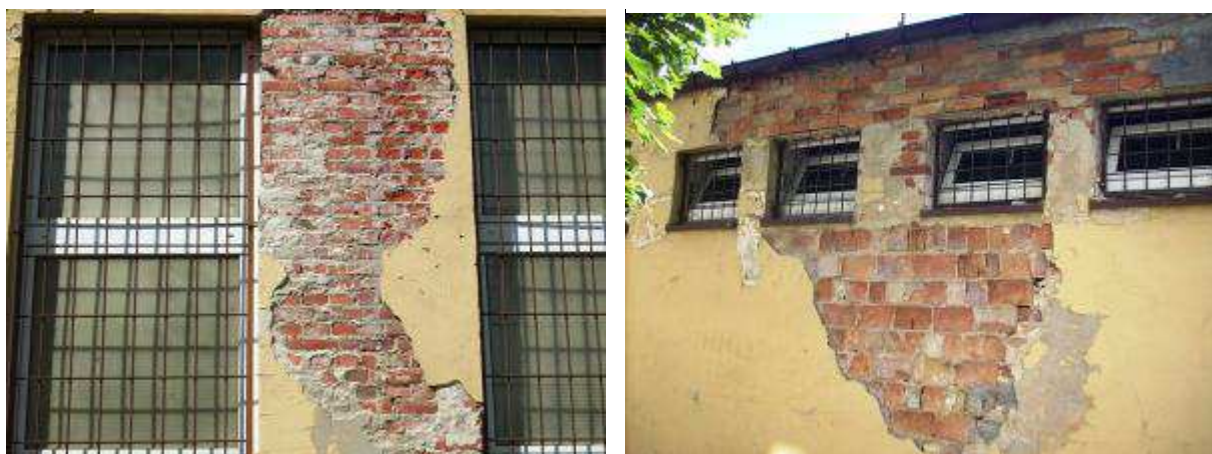
Rysunek 14 Widok fragmentów ścian budynku sali gimnastycznej
