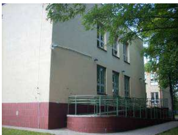
Rysunek 12 Widok elewacji szczytowej (północnej) budynku Gimnazjum
