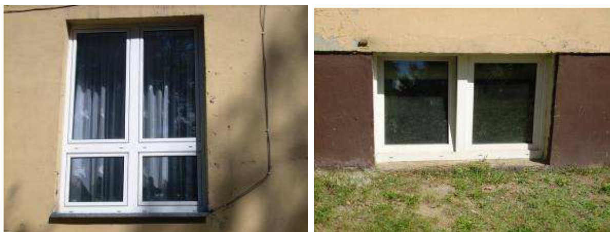
Rysunek 18 Widok typowych okien budynku szkoły
