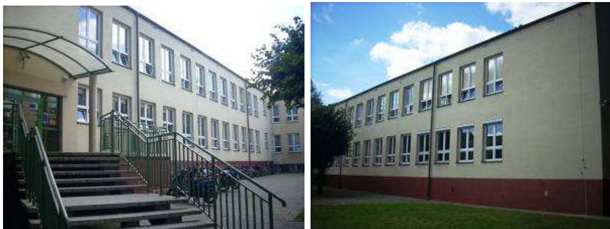
Rysunek 11 Widok elewacji zachodniej i wschodniej budynku Gimnazjum (budowa 2004 r)
