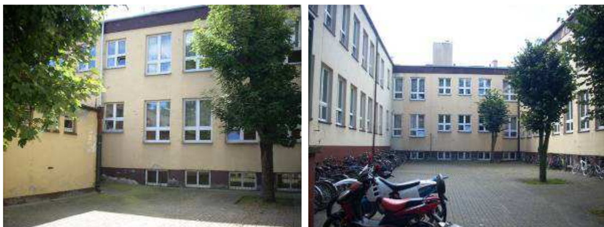
Rysunek 6 widok fragmentów elewacji północnej budynku podłużnego oraz elewacji zachodniej budynku Gimnazjum i elewacji wschodniej budynku frontowego Szkoły Podstawowej
