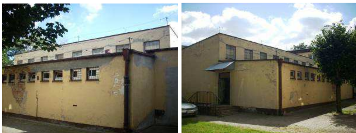
Rysunek 9 Widok elewacji zachodniej i północnej budynku sali gimnastycznej
