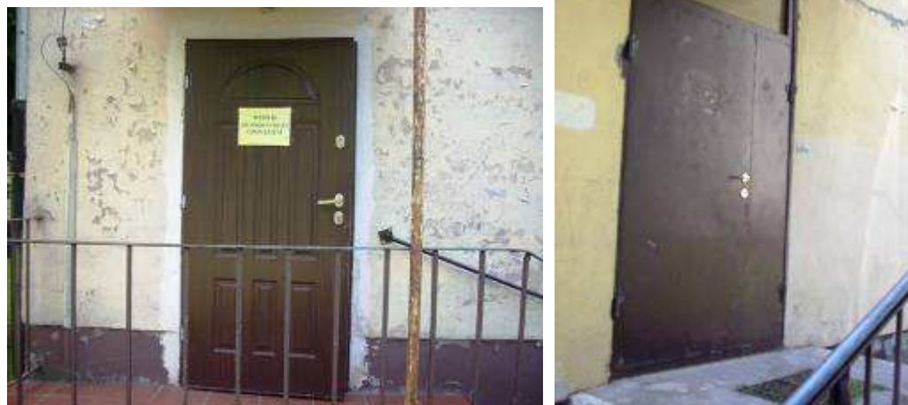
Rysunek 17 Drzwi nowe wejścia do budynku Szkoły Podstawowej (el. szczytowa zachodnia) oraz do budynku zaplecza sali gimnastycznej
