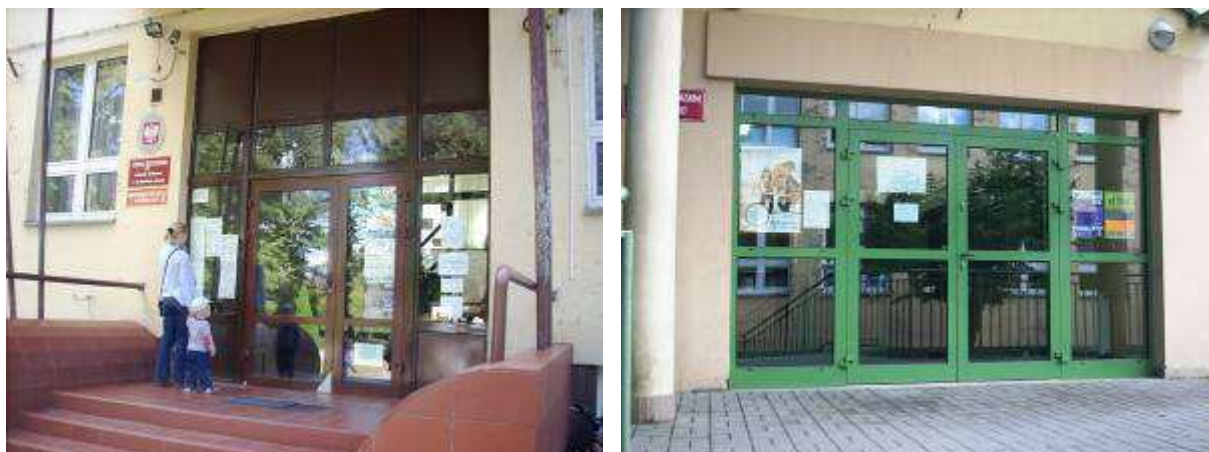
Rysunek 16 Drzwi AL. nowe wejścia głównego (elewacje zachodnie) do budynków Szkoły Podstawowej i do budynku Gimnazjum
